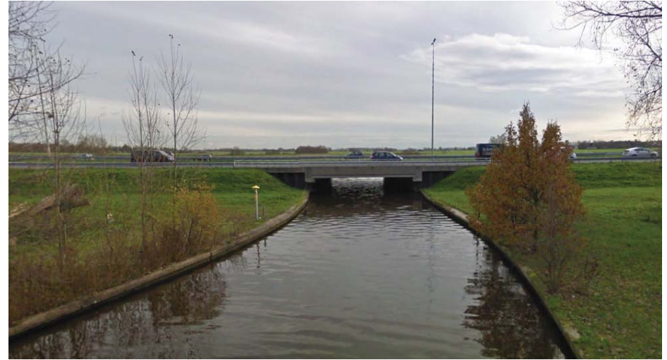
↑ TE VERBREDEN KUNSTWERK (KW34): DUIKERRUG BAKKERSLOOT
