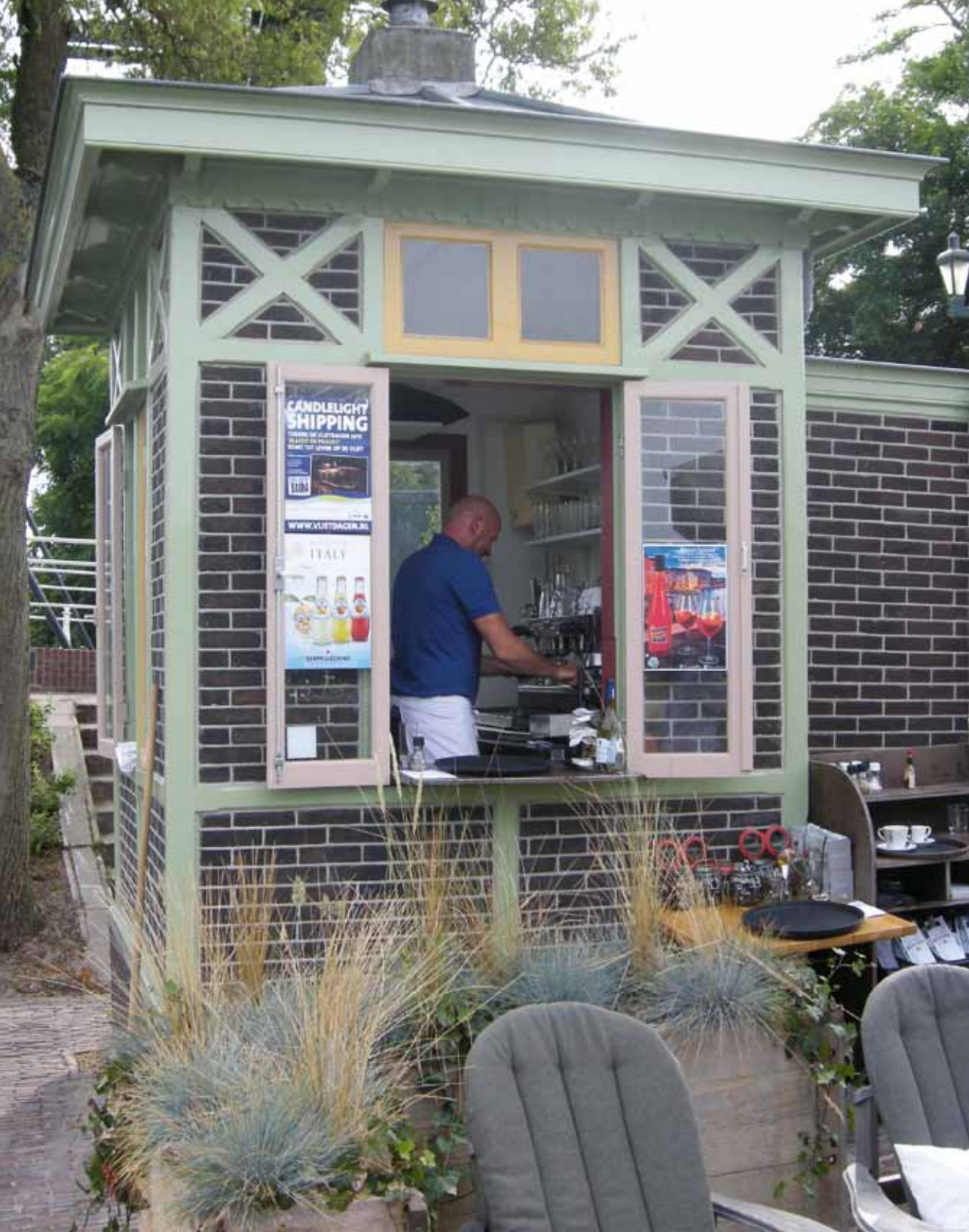
Brugwachtershuisje Kerkbrug, Voorburg
