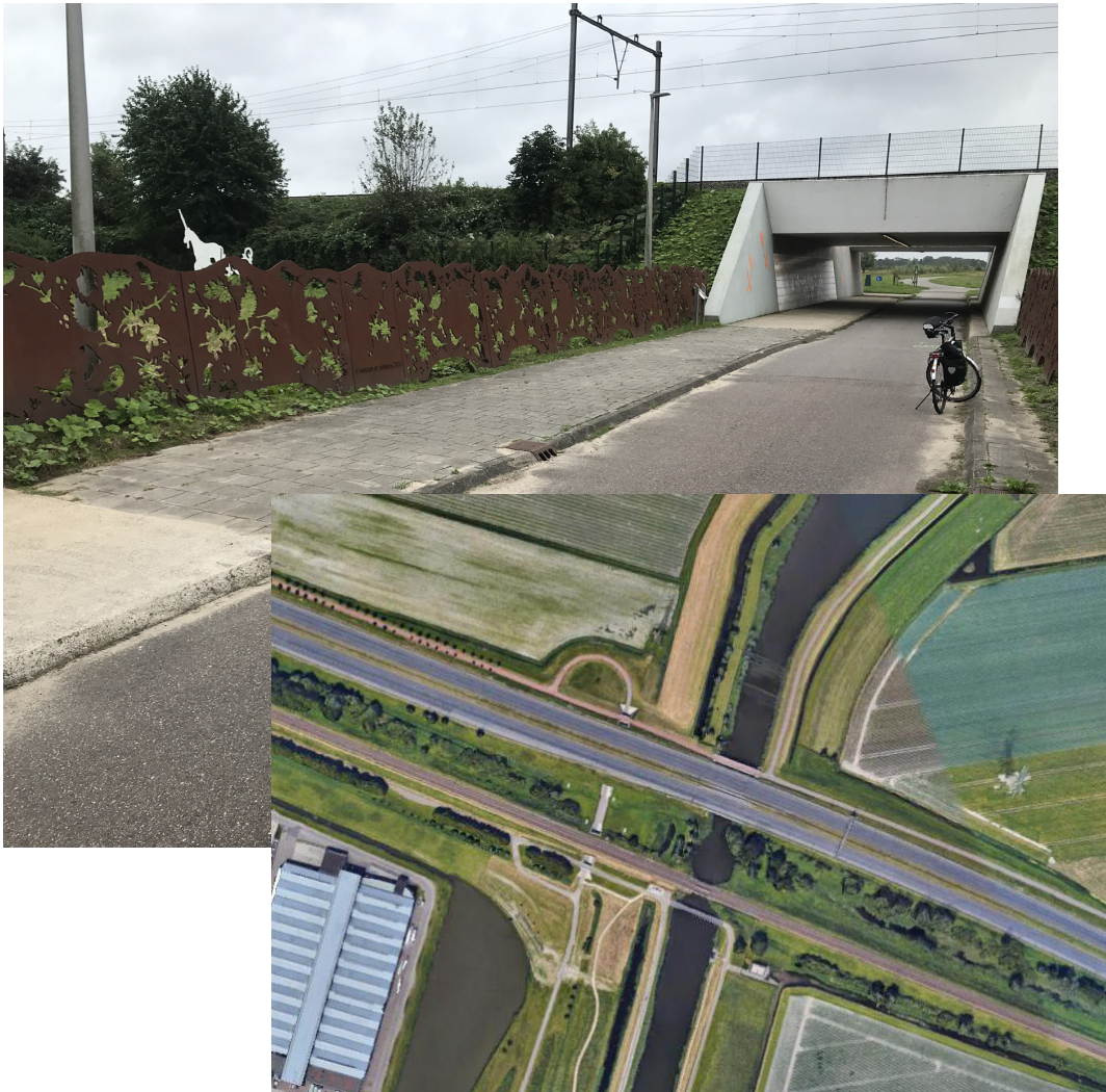
'Tussenland' in passage snelweg A12 en spoorlijn Den Haag - Utrecht; foto kijkend naar zuiden september 2021 en opname Google Earth
