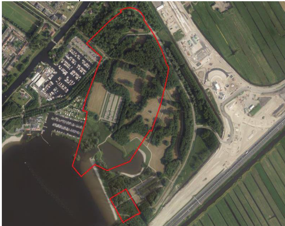
Fig. 1: Kaart plangebied met recreatie en horeca (onderste deel) en verblijfsrecreatie (bovenste deel). De werkzaamheden aan de Rijnlandroute (noord en oost) zijn goed zichtbaar.
