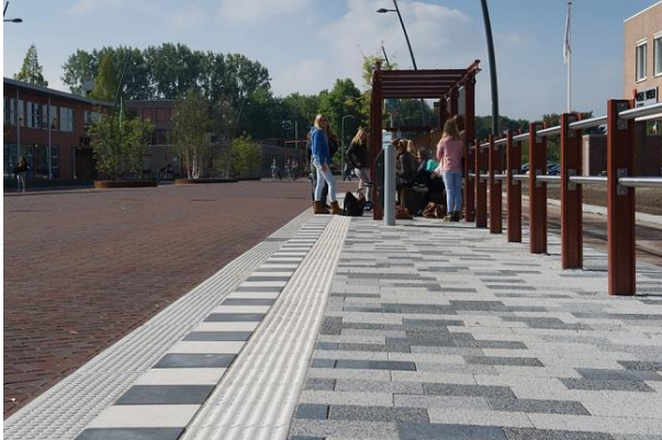
Figuur 2: foto van halte met een geleidelijn over de gehele lengte van het perron (foto: https://struykverwoinfra.nl/geleidelijntegels.html )
