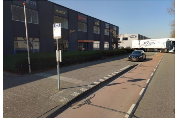
Figuur 3: foto van halte in Dordrecht met enkel een aansluitende geleidelijn, zonder geleidelijn over hele lengte perron (foto: cyclomedia)
