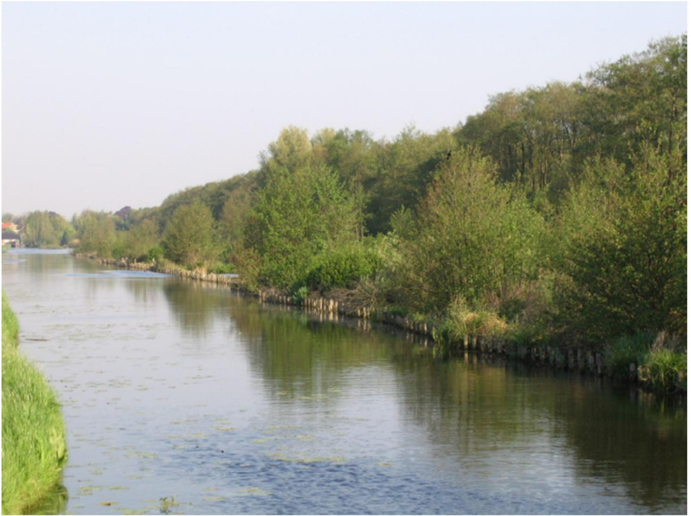
Stolwijkse boezem: aangelegd voor tijdelijke wateropslag.
