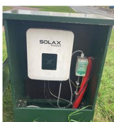
Defecte omvormer en connector kapotte paneel in plastic zak:
