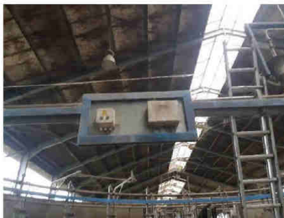
Foto 4: Rechtsboven de draaikop met glijcontacten.
