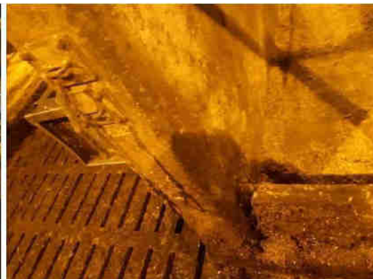
Verbinding tussen waterbak en ligbox
