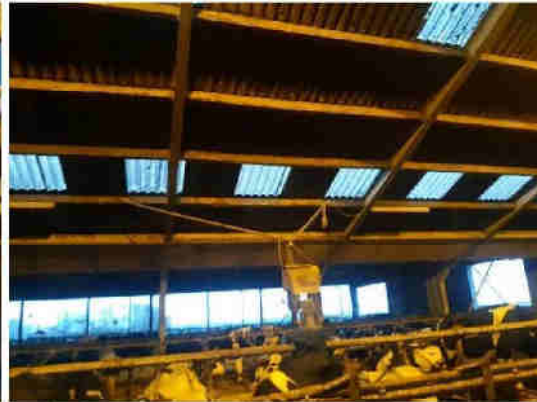
Verbinding tussen voerboxen en staalconstructie stal
