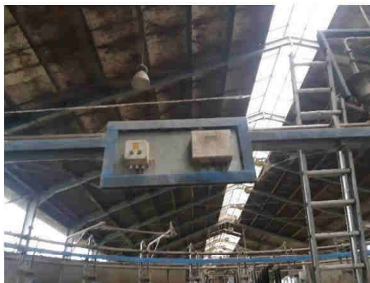
Foto 4: Rechtsboven de draaikop met glijcontacten.
