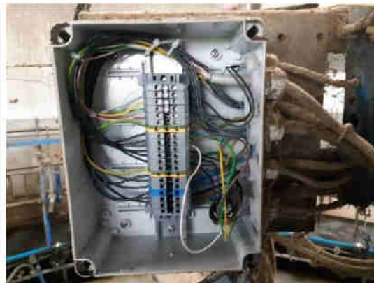
2 Aansluitdoos met bekabeling vanuit besturingskast
