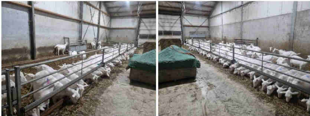
De voerhekken van de jongveestal zijn mechanisch verbonden met de staalconstructie van de stal
