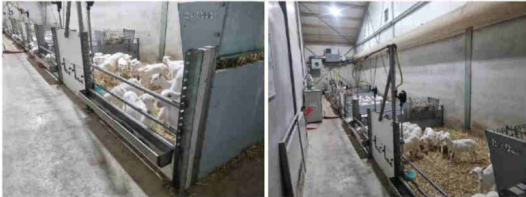
De metalen constructies van hekwerken van jongveeststal afdeling 2 zijn onderling doorverbonden.
