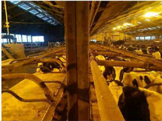
Ligboxen verbonden met staalconstructie
