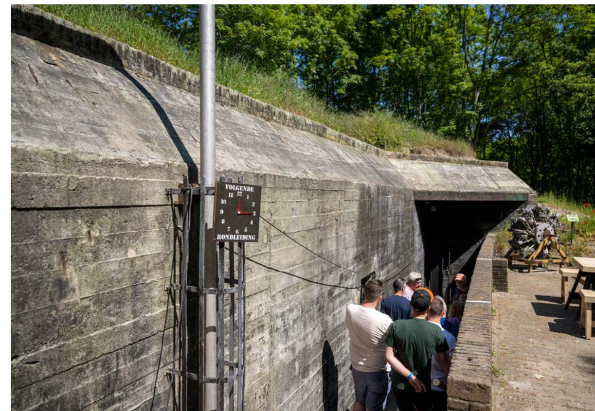
De Biber Bunker Oostvoorne
