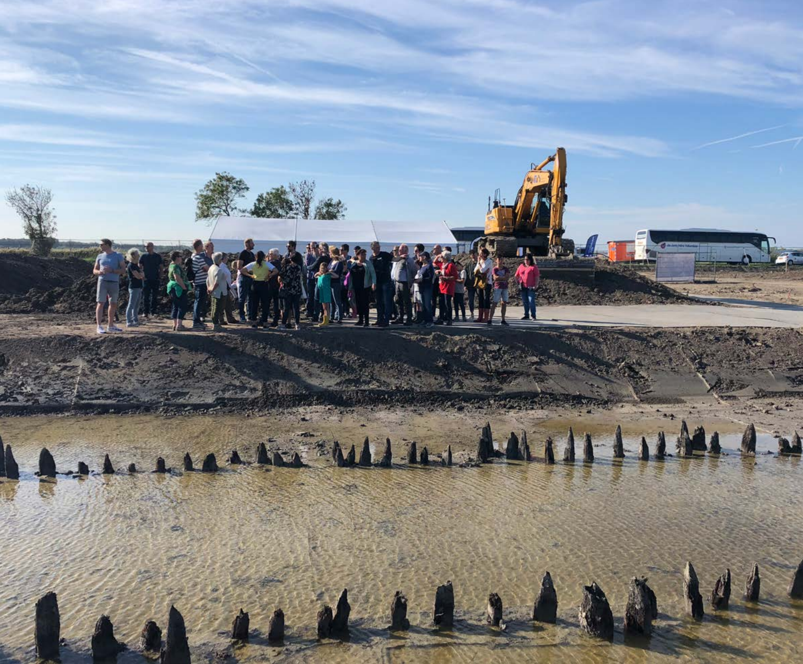
Opraving Romeinse weg, Rijnlandroute, Valkenburg (Weerdkampen)
