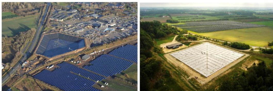
Figuur 11.9 Voorbeelden grootschalige thermische putten. Links: Vojens, Denemarken (in aanbouw, 200.000 m 3 ) (bron: Solar Heat Europe 90 ). Rechts Dronninglund, Denemarken (60.000 m 3 ) (bron: Solarthermalworld 91 )
