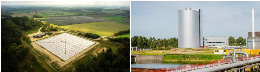
Figuur 12 Voorbeelden warmteopslag. Links: ondergrondse opslag Dronninglund, Denemarken (bron: Solarthermalworld), rechts: bovengrondse warmteopslag Vattenfall Diemen
