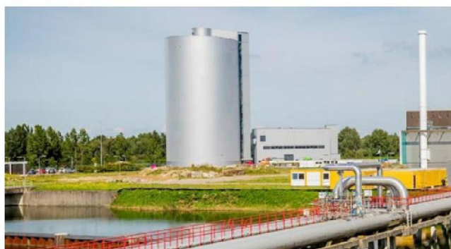
Figuur 1.12 Bovengrondse warmteopslagtank Diemen (bron: Vattenfall, via Expertisecentrum Warmte)
