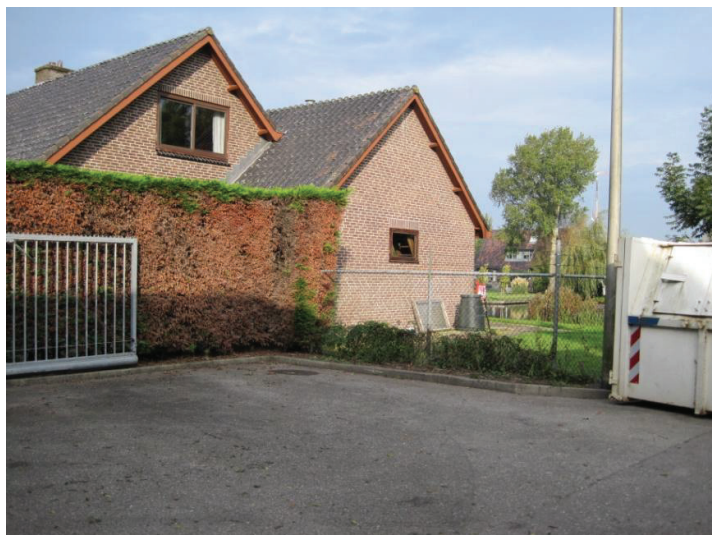
Foto 04, naast gelegen woning
