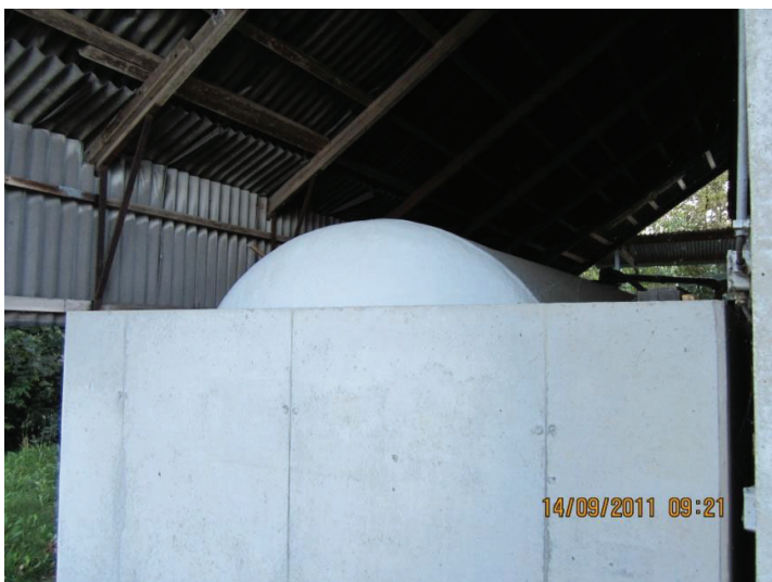
Foto 08, te verwijderen tank (aanbouw zoutloods (2))
