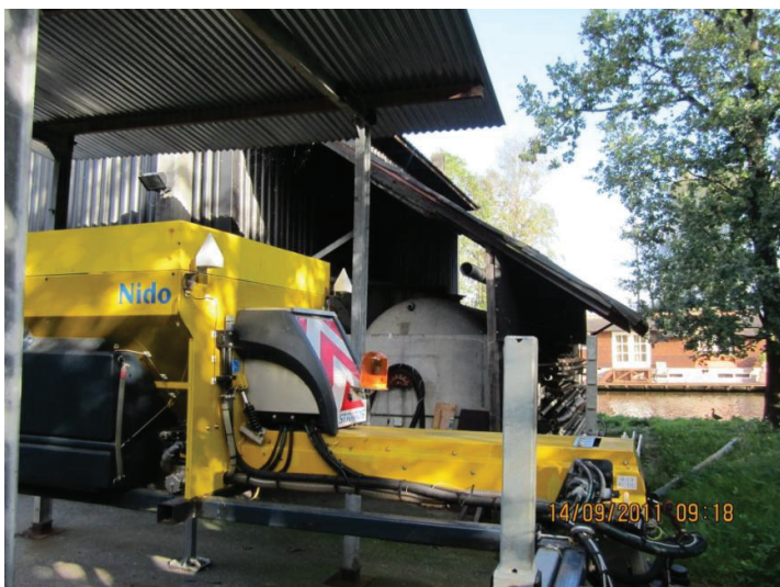
Foto 07, te slopen aanbouw zoutloods (3) en overkapping (4)
