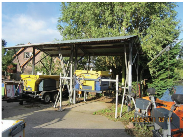
Foto 05, te verwijderen overkapping (1) en kraan
