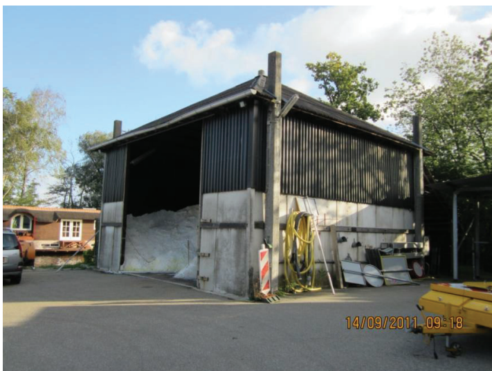
Foto 06, te slopen zoutloods (2)
