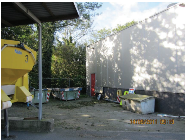
Foto 11, zijgevel bestaande bebouwing
