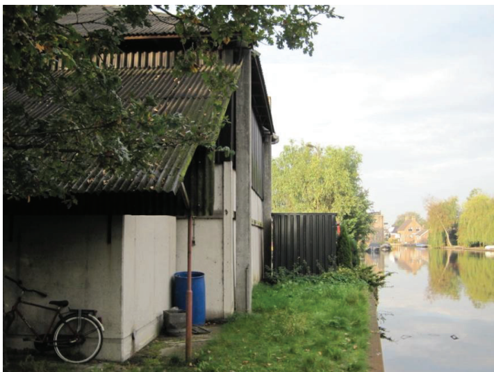
Foto 09, kade langs zoutloods (2), te verwijderen opslagcontainer
