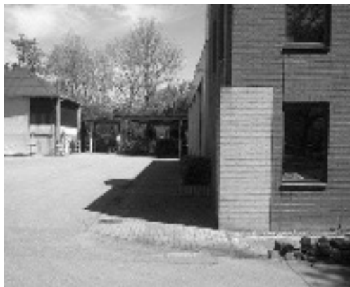
Zicht op zoutloods (links) en kantoor/werkplaats (rechts)
