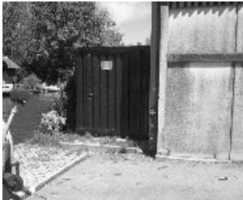
Noordzijde loods vanuit zuidwestelijke richting gezien
