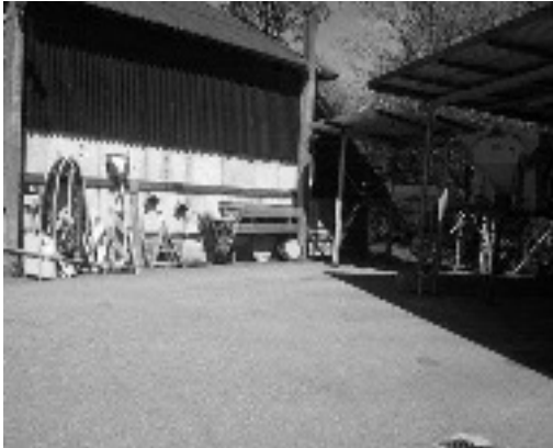
Zicht op zoutloods(links) en overkapping (rechts)
