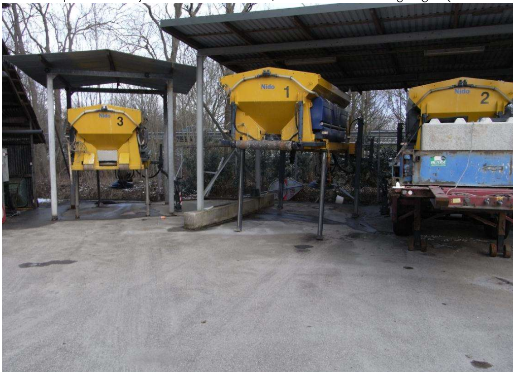
Foto 2 Opstellen oostzijde locatie waar de olie/benzine afscheider is gelegen (februari 2013)
