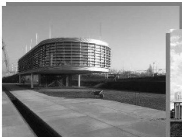
Bedieningscentrale Steekterpoort- Provincie Zuid-Holland
