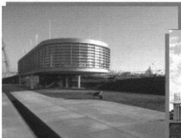
Bedieningscentrale Sleekterpoort- Provincie Zuid-Holland
