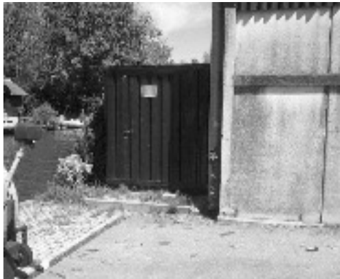
Noordzijde loods vanuit zuidwestelijke richting gezien
