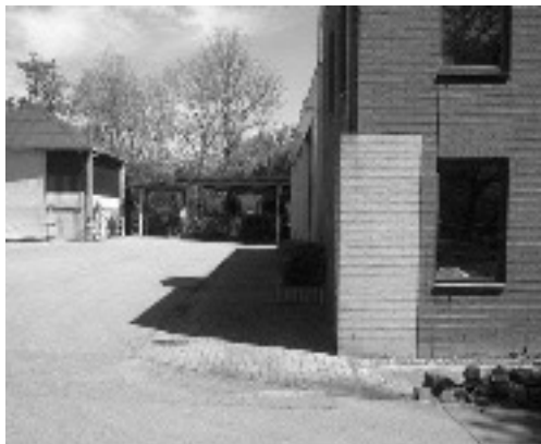
Zicht op zoutloods (links) en kantoor/werkplaats (rechts)
