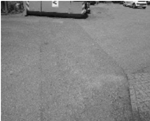
Reparatievak asfalt aan de westzijde locatie
