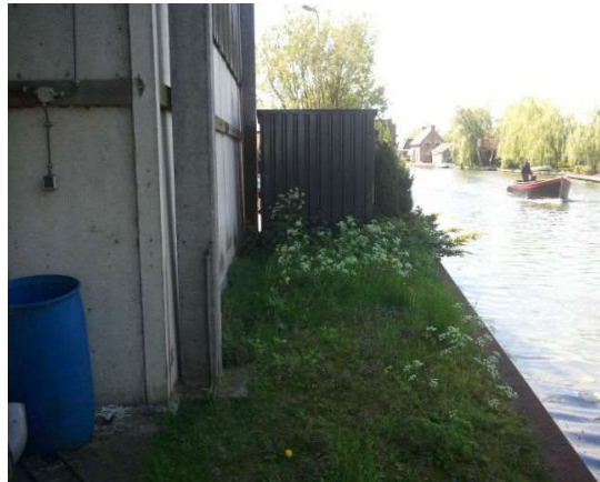
Noordzijde zoutloods vanuit oostelijke richting gezien
