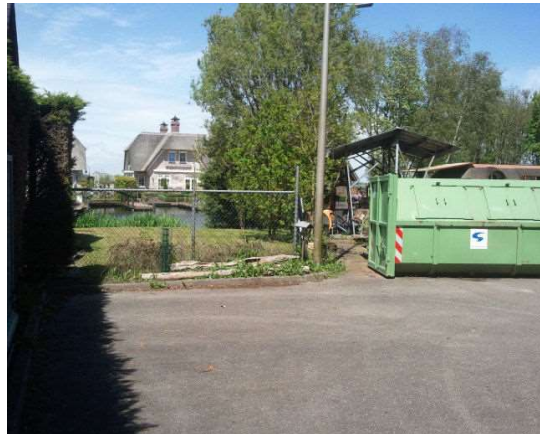
Westelijk deel locatie vanuit zuidwestelijke richting
