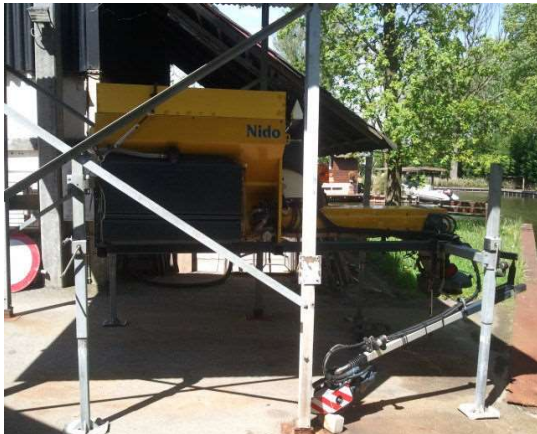
Bovengrondse tank met zoutoplossing ten oosten van zoutloods
