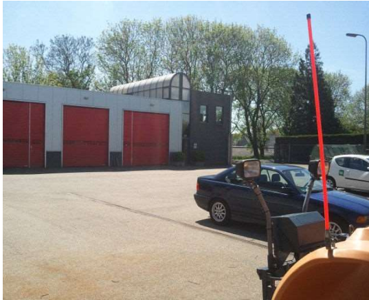
Kantoor/werkplaats vanuit noordoostelijke richting
