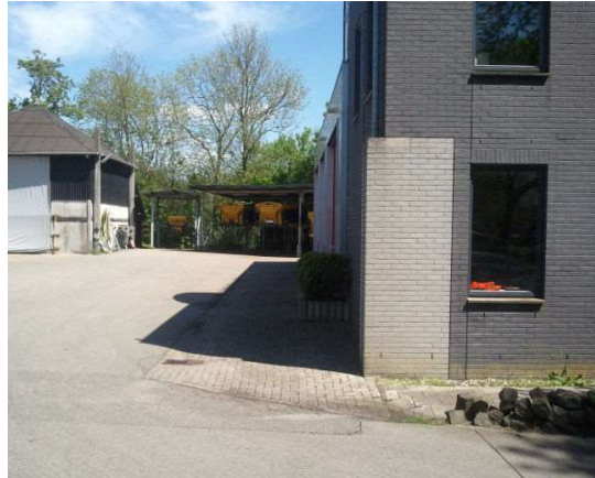
Zicht op zoutloods (links) en kantoor/werkplaats (rechts)
