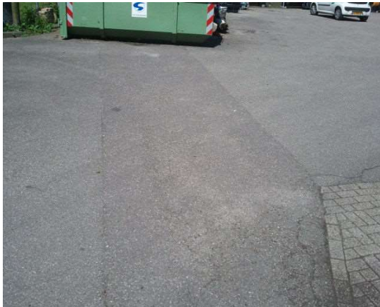
Reparatievak asfalt aan de westzijde locatie
