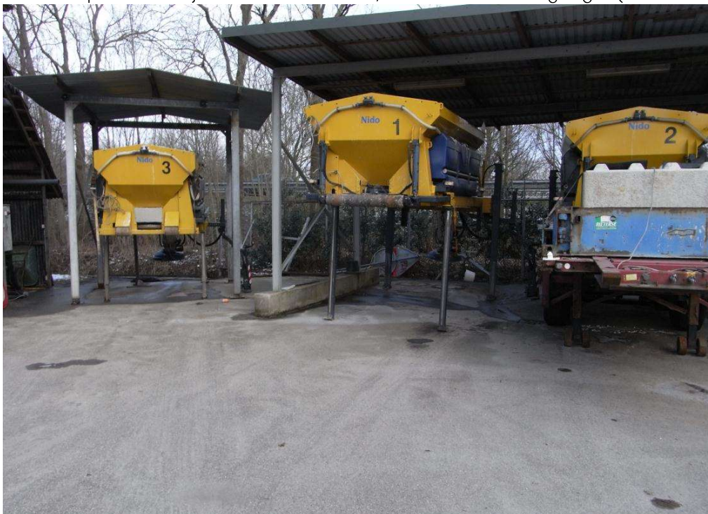
Foto 2 Opstallen oostzijde locatie waar de olie/benzine afscheider is gelegen (februari 2013)
