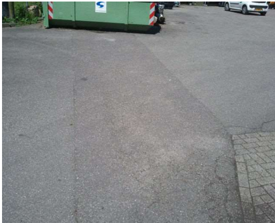
Reparatievak asfalt aan de westzijde locatie
