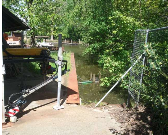
Zijarm kanaal gezien vanuit zuidelijke richting
