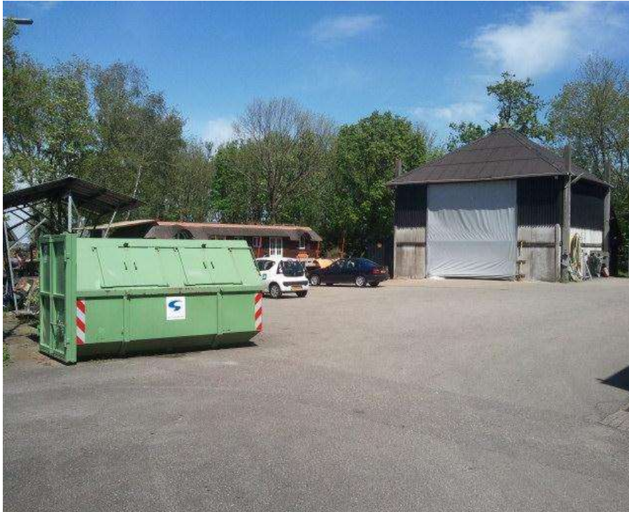
Foto 1 Zicht op zoutloods en locatie nader bodemonderzoek naar PAK in grond (mei 2012).
