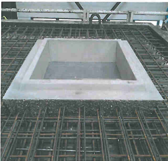
Betonring opgenomen in de wapening
