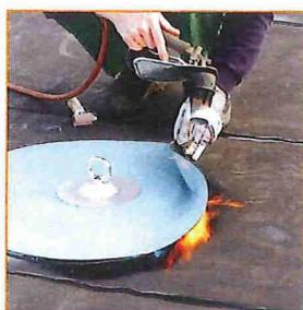
Als de Kedge belast wordt, gebeuren er verschillende dingen. Allereerst vervormt de in de Kedge aanwezige kreukelzone. Hierdoor wordt een deel van de energie, die vrijkomt tijdens de val, opgenomen. De overige energie wordt over de rondom aanwezige dakbedekking afgevoerd. Op die manier wordt handig gebruik gemaakt van de flexibiliteit, de sterkte en de massa van de dakbedekking.
