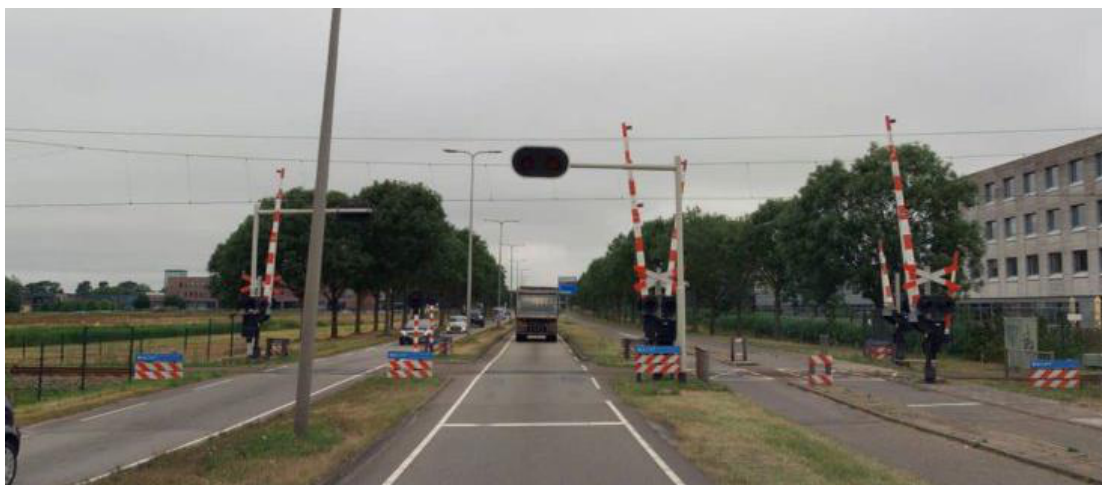
Figuur 10: bestaande situatie gelijkvloerse spoorwegovergang Leidse Schouw
