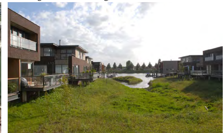
geen voorbelasting, bestaande bodem behouden
