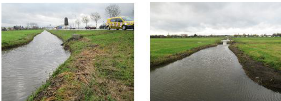
Figuur 5.7: Onderdoorgang N206 ter hoogte van de ecologische verbingszone. Links: zij aanzicht, Rechts: zicht vanuit de duiker naar het westen.
