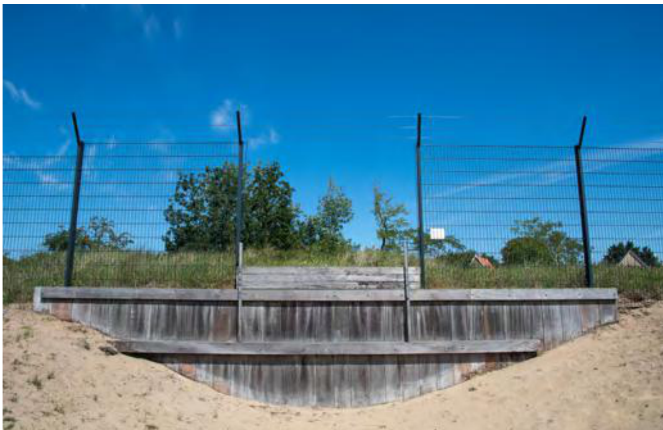
Inspringopening in het damhertkerend hek. Damherten kunnen van buiten het hek wel de AWD in springen, maar ze kunnen niet de AWD uit springen.
