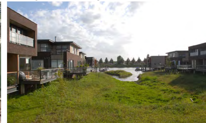
geen voorbelasting, bestaande bodem behouden
