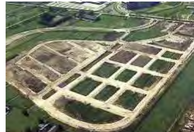
zand onder rijbanen, grond in groenstructuren en tuinen
