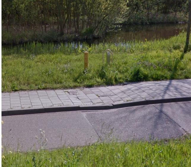
Figuur 5.1: Afsluiters gasleiding langs fietspad.
