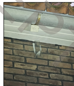
Figuur: voorbeeld van een exclusion flap en vulschuim bij een dakgoot.
