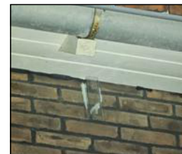
Figuur: voorbeeld van een exclusion flap en vulschuim bij een dakgoot.
