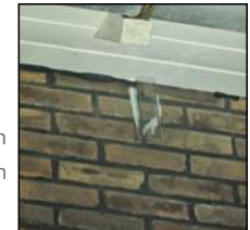
Figuur: voorbeeld van een exclusion flap en vulschuim bij een dakgoot.
