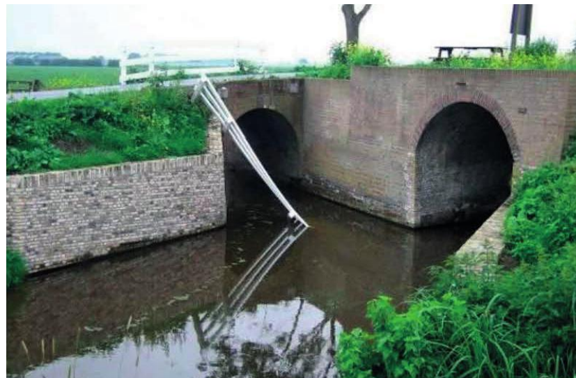
De herstellde heul en een sluisje in de Tiendweg. (Bron: Den Besten 2008)
