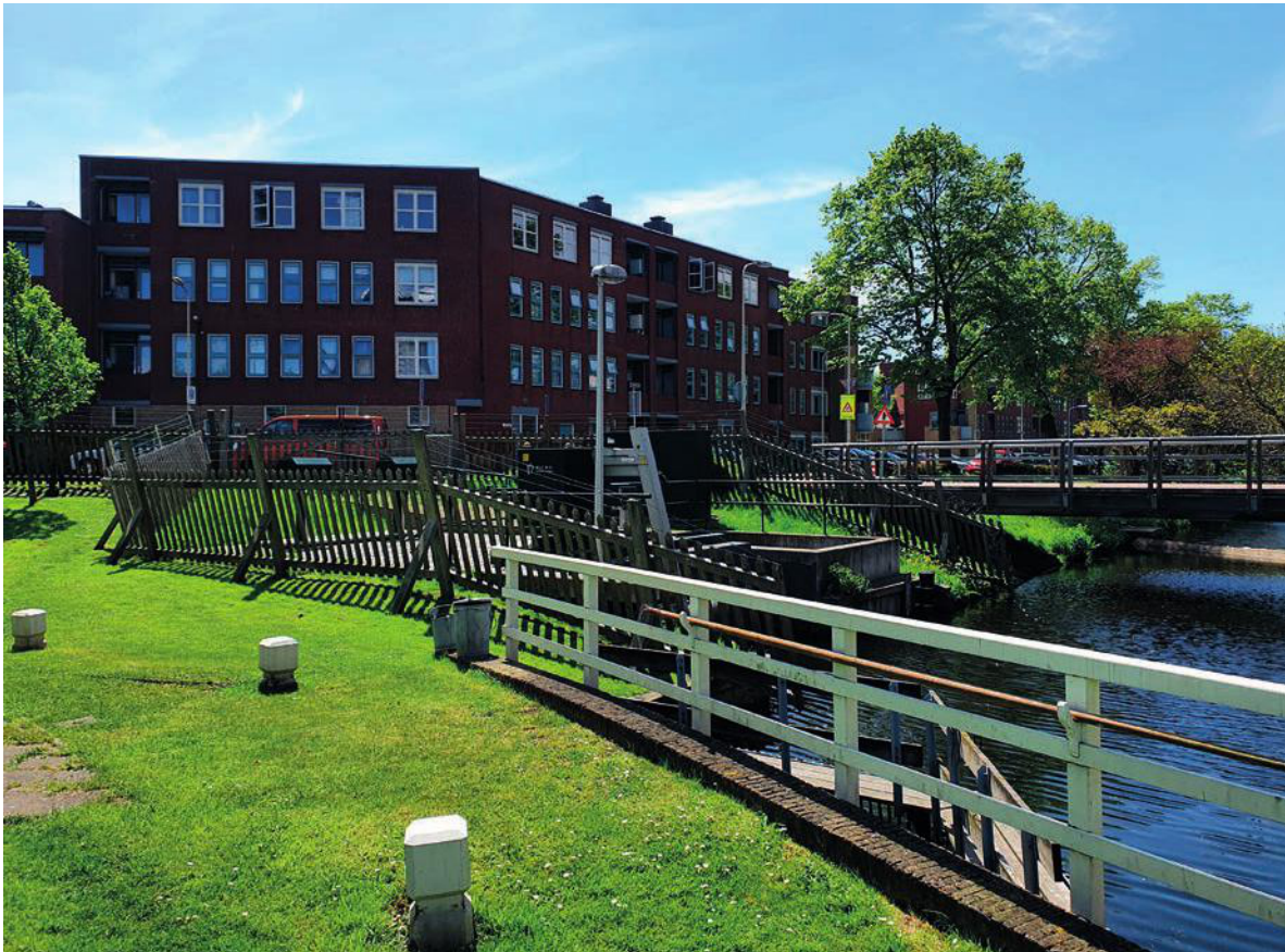
Het gemaal aan de Laakkade ten westen van de molen.
