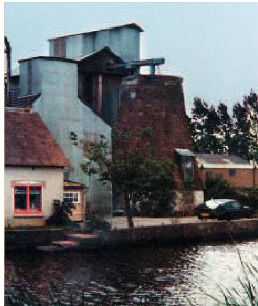
De molenplaats ten tijde van het mengvoederbedrijf in 1970. Van De Jonge Sophia resteert de romp. Via een transportschroef is de graansilo verbonden met de molenromp. Op de voorgrond de aanlegplaats met stenen stoep voor boten. (Bron: Vereniging De Hollandsche Molen)
