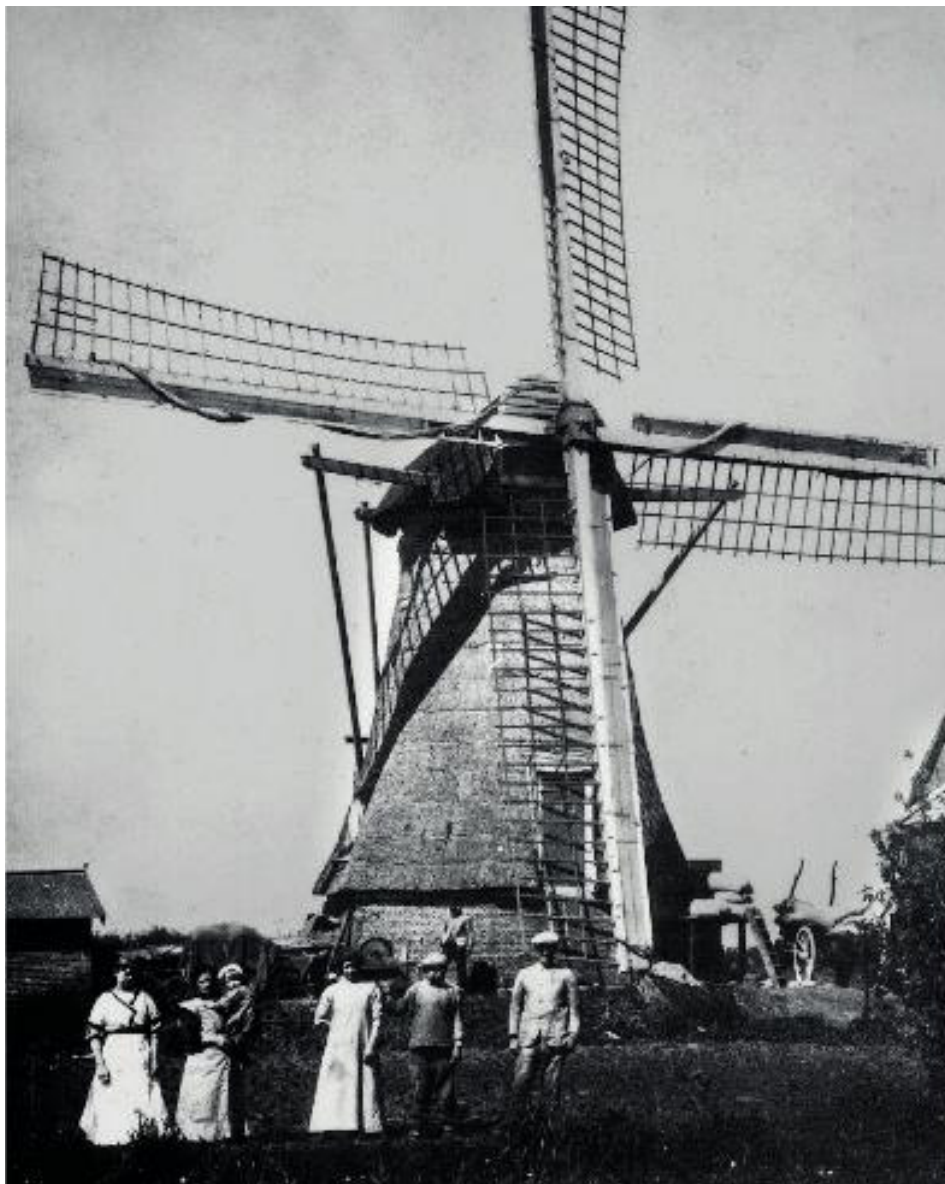
De Jonge Sophia in Ottoland (1912) Rechts van de molen staat een zakkenbank met trap die wordt geladen met zakken graan van een kar. (Bron: Vereniging De Hollandsche Molen)
