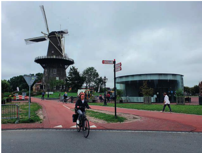
De ingang van parkeergarage Lammermarkt naast de molen.
