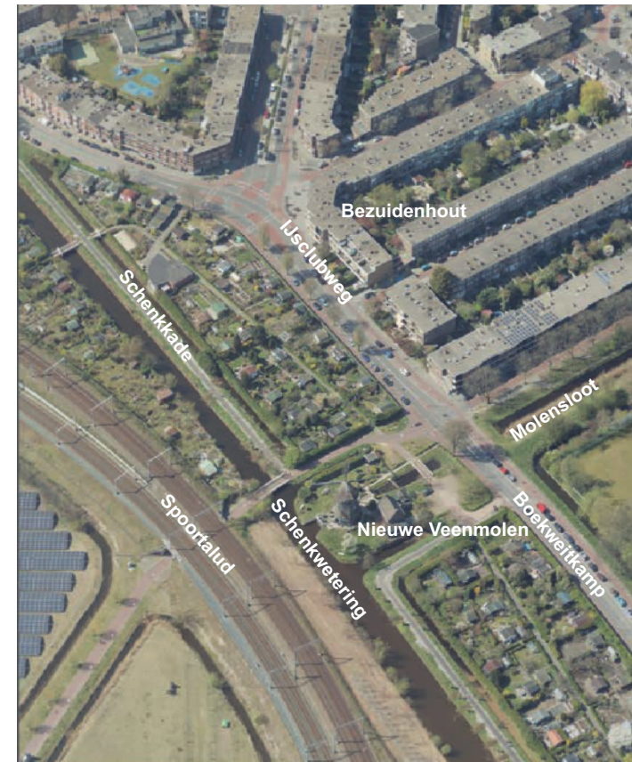
Luchtfoto uit 2020 (Bron: Streetsmart/Cyclomedia)
