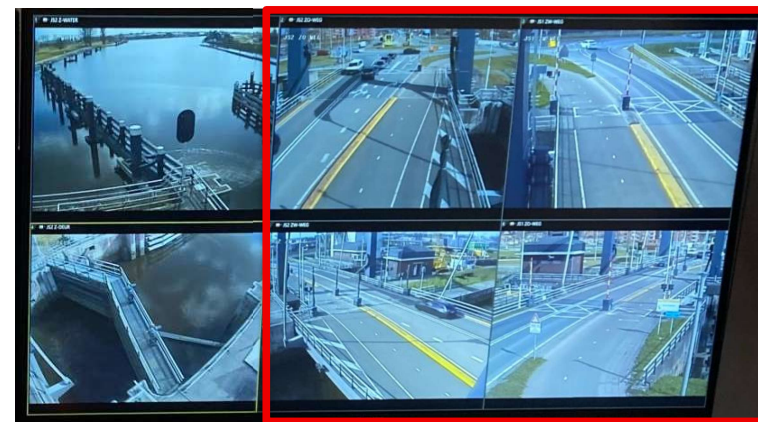
Figuur 14. Camerabeelden rechterscherm JS2 (zuidzijde). De beelden in het rode kader bieden zicht op de brug.
