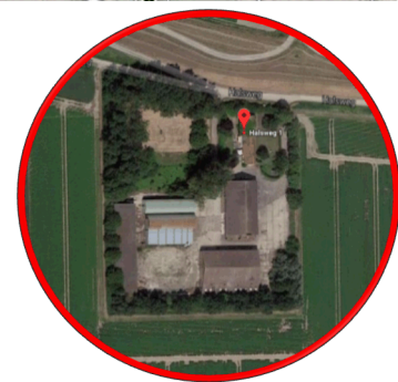
3. Te saneren perceel: Halsweg 1-3
