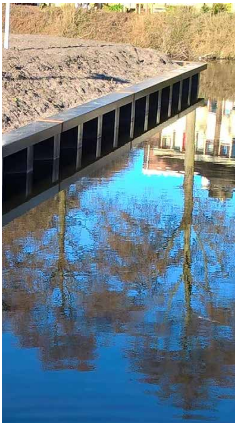
Stalen damwanden met deksloof als beschoeiing onder spoorbrug en brug Parallelweg ter plaatse van versmalling boezemkanaal
