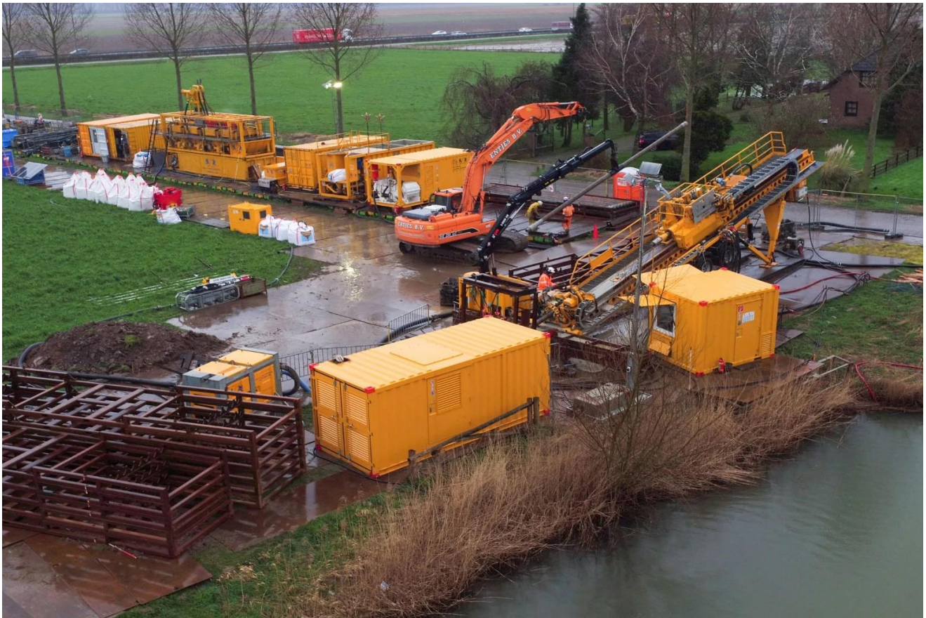
Figuur 5-8 Boorstelling (rig) voor de uitvoering van een horizontaal gestuurde boring.
