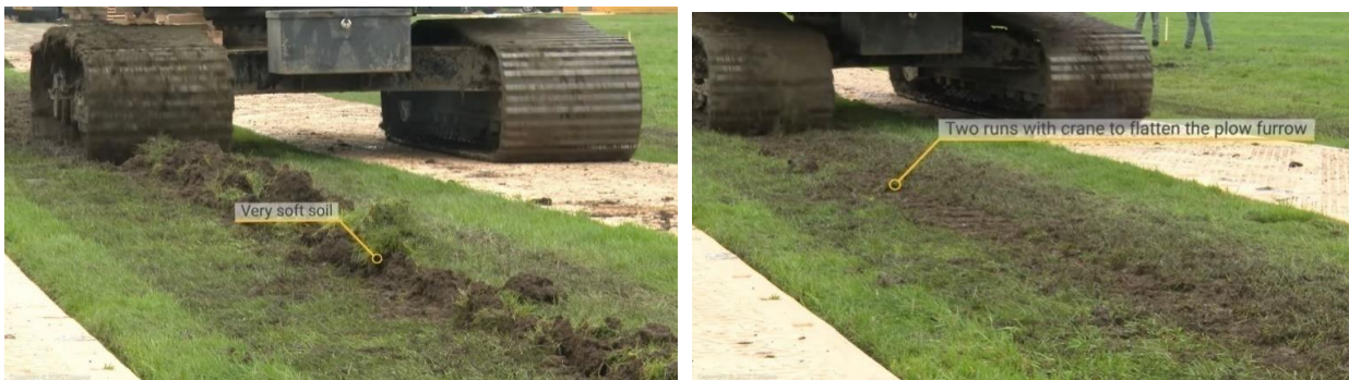
Figuur 5-6 Gasunie testproject inploegen in Sliedrecht (april 2022, foto Gasunie).
