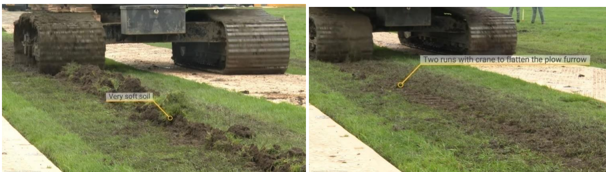
Figuur 3-4 Gasunie testproject inploegen in Sliedrecht (april 2022, foto Gasunie).
