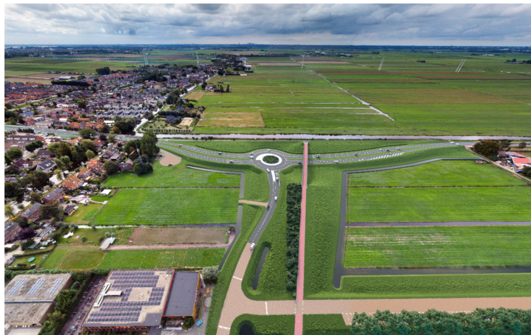
Bovenaanzicht rotonde noord en fietsbrug Hazerswoude-Dorp
