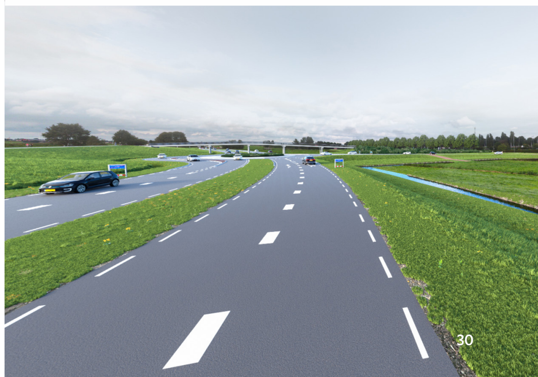
Rotonde noord en fietsbrug
