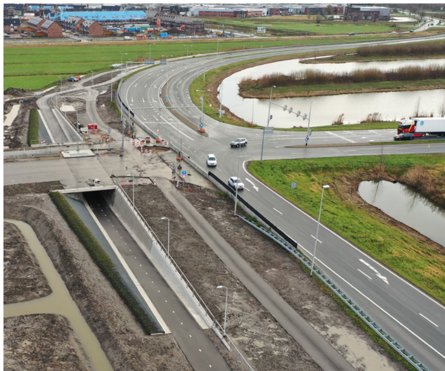
Aanleg Vredenburglaan, kruising N451
