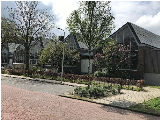
Foto: 5 bouwlokalen Schoonhovens College, locatie Vlisterveg 22
