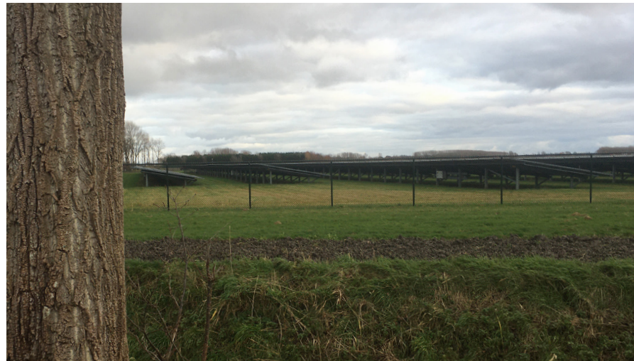
Zicht vanaf de langs liggende weg: tegen de hekken en panelen
