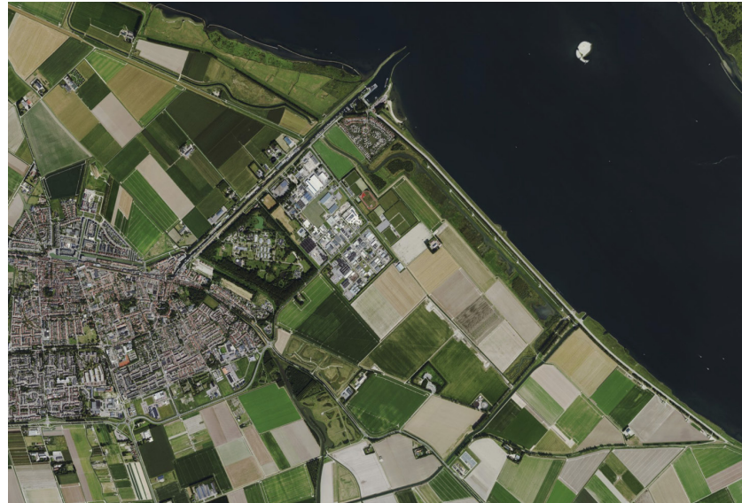
Locatie windpark bij Middelharnis
