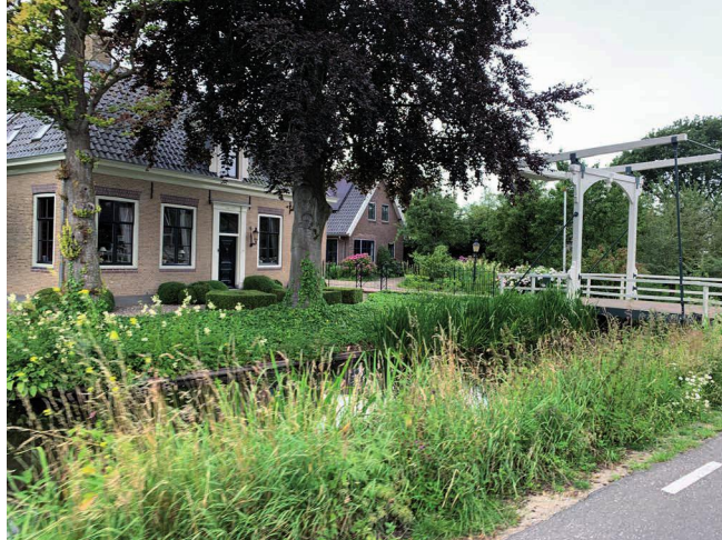
Karakteristieke bebouwing en ophaalbruggen per erf.
