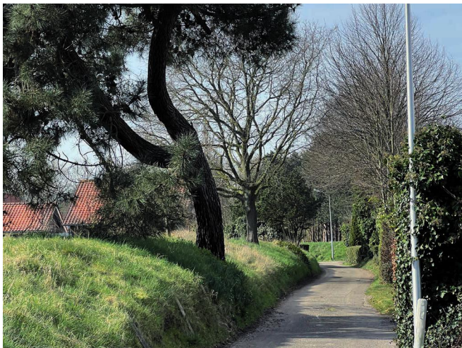
Zandwallen en schurvelingen langs de weg. Eenvoudige wegprofielen zonder trottoirs en fietspaden, als landwegen.
