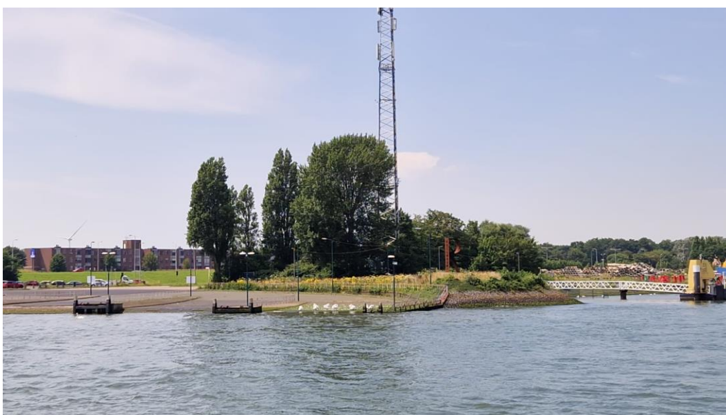
Situatie met veerstoepen (links) en loopbrug naar ponton (rechts) aan de Rozenburgzijde
