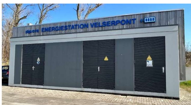
Figuur 4 Energiestation Velsen-Noord
