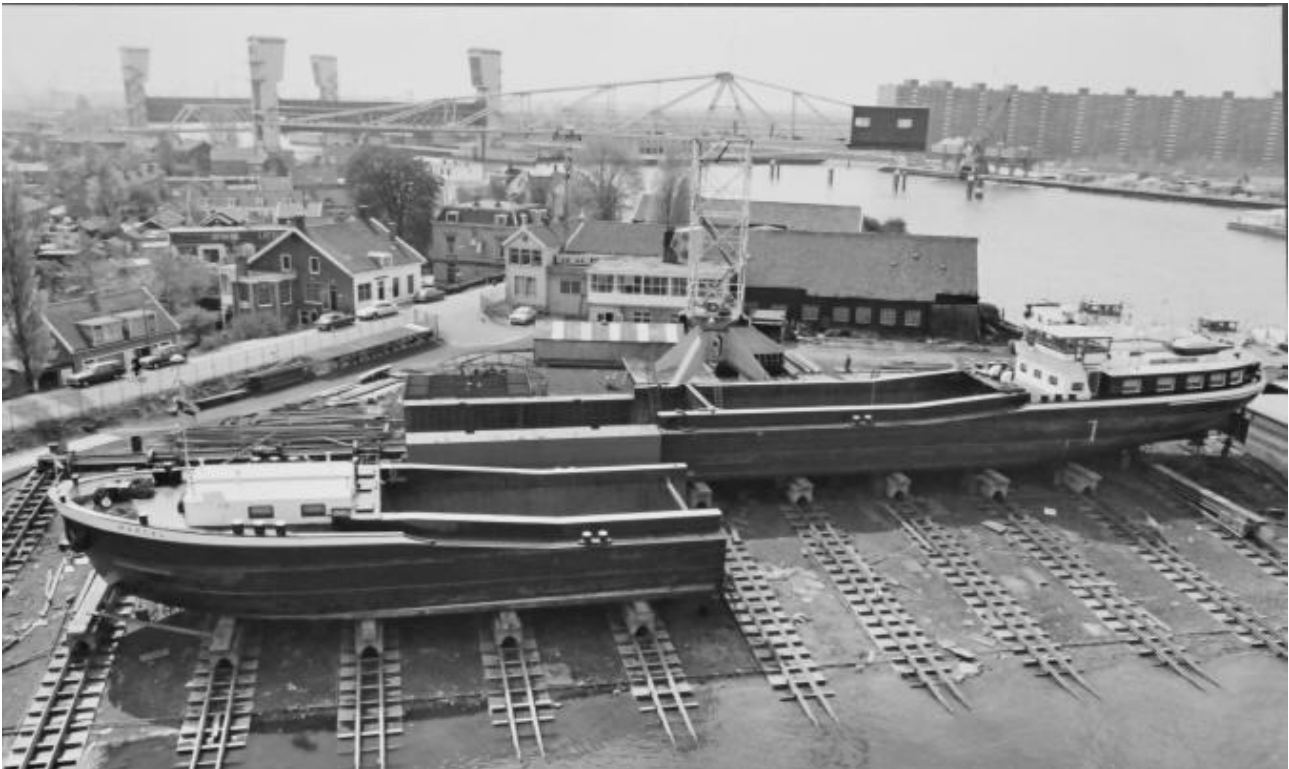
Figuur 10 Verlenging van de MS 'Marcel' bij Van der Giessen-de Noord (via: historischekringkrimpen.nl )
